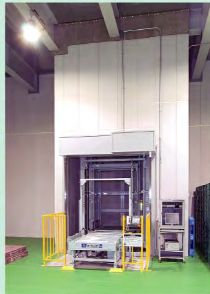
※1F防火シャフト内設置
