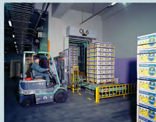
定温倉庫(木パレット)
