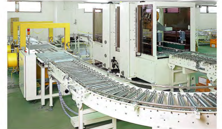
上フラップ折機・テープ封函機/衣料品流通センター
