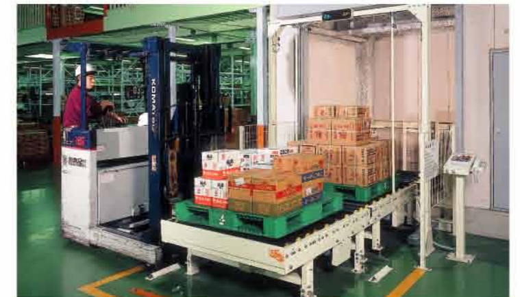
パーチレーター大型 / 物流センター
