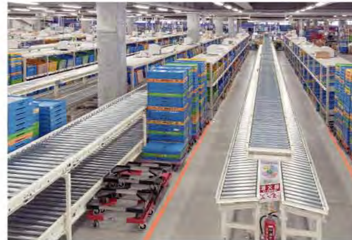
DIY商品物流センター / リング駆動ローラーコンベヤ&リップベルト駆動ローラーコンベヤ
