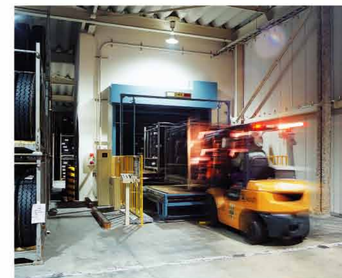
オートレーター大型/パレット循環/物流倉庫
