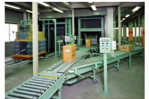
配送センター / リング駆動ローラーコンベヤ&スイングユニット
