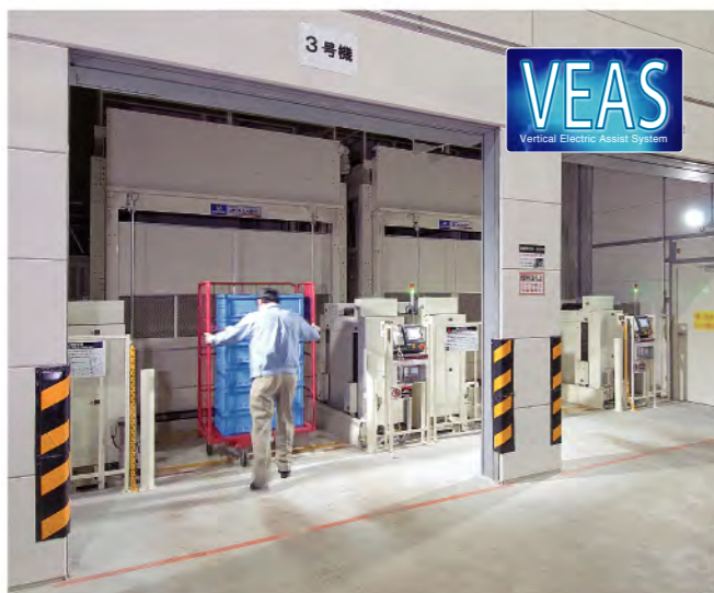
オートレーターV大型フロア循環Eタイプ/ホームセンター関連商品物流センター
