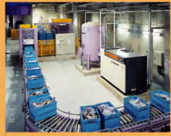
●リサイクルセンター搬送ライン
