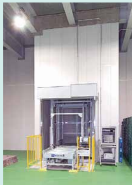
※1F防火シャフト内設置
